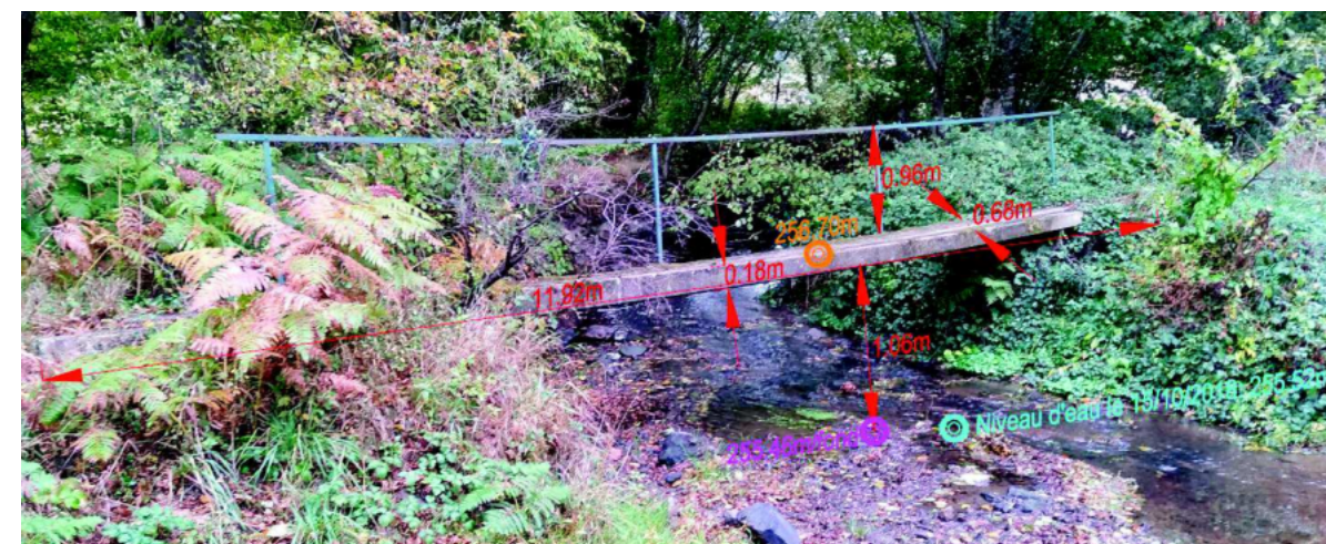
Figure 9 : Photographie cotée de la passerelle au niveau du lieu-dit "Puy Roger" (source : Antea Group)
